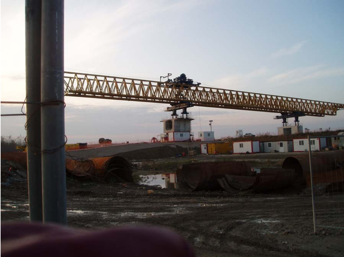
Снимка от работата на моста Видинъ Calafat(30.11.2009)
